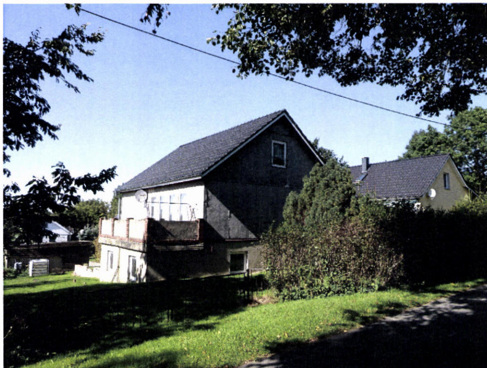
Abb. 14: Am Mühlberg Nr. 39 – mit vermutlich ursprünglichem Zustand der Fassade
