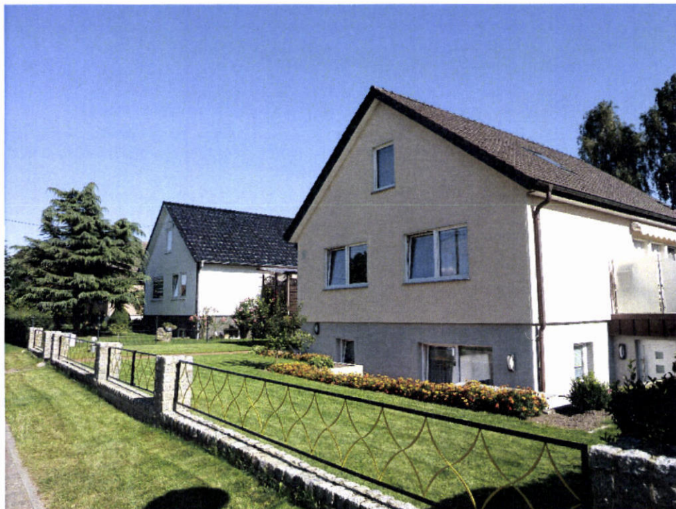
Abb. 13: Einfriedungen zur öffentlichen Straße (2)
