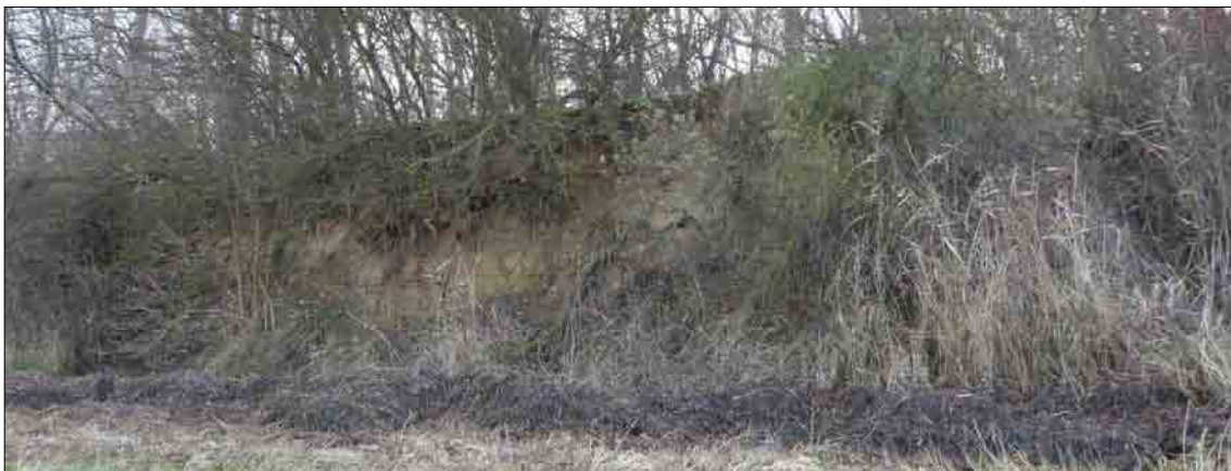
Abbildung 20: Steile Abbruchkante ca. 200-250 m nordöstlich des Strandzugangs. Quelle: STADT LAND FLUSS 05.12.2016
