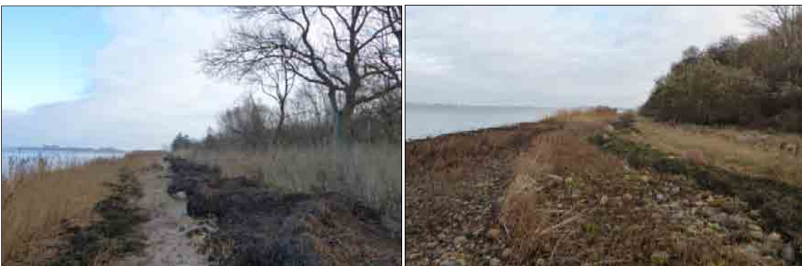
Abbildung 17: Blick in Richtung Nordosten auf das Boiensdorfer Werder. Quelle: STADT LAND FLUSS 05.12.2016
