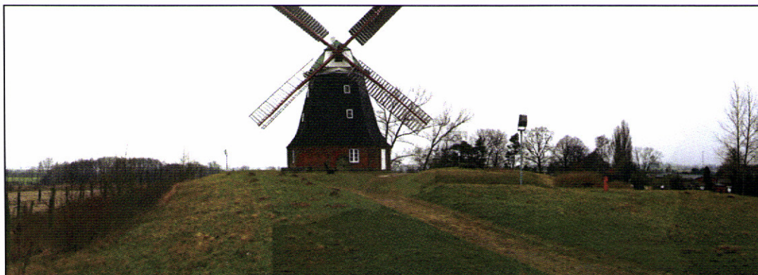
Abbildung 27: Blick aus Richtung Westen. In dieser Perspektive sind die Windmühle sowie die vorhandene Bebauung sichtbar. Die geplanten Ferienhäuser könnten links neben der Windmühle mit dem Firstbereich sichtbar sein. Foto: STADT LAND FLUSS 21.02.2014.
