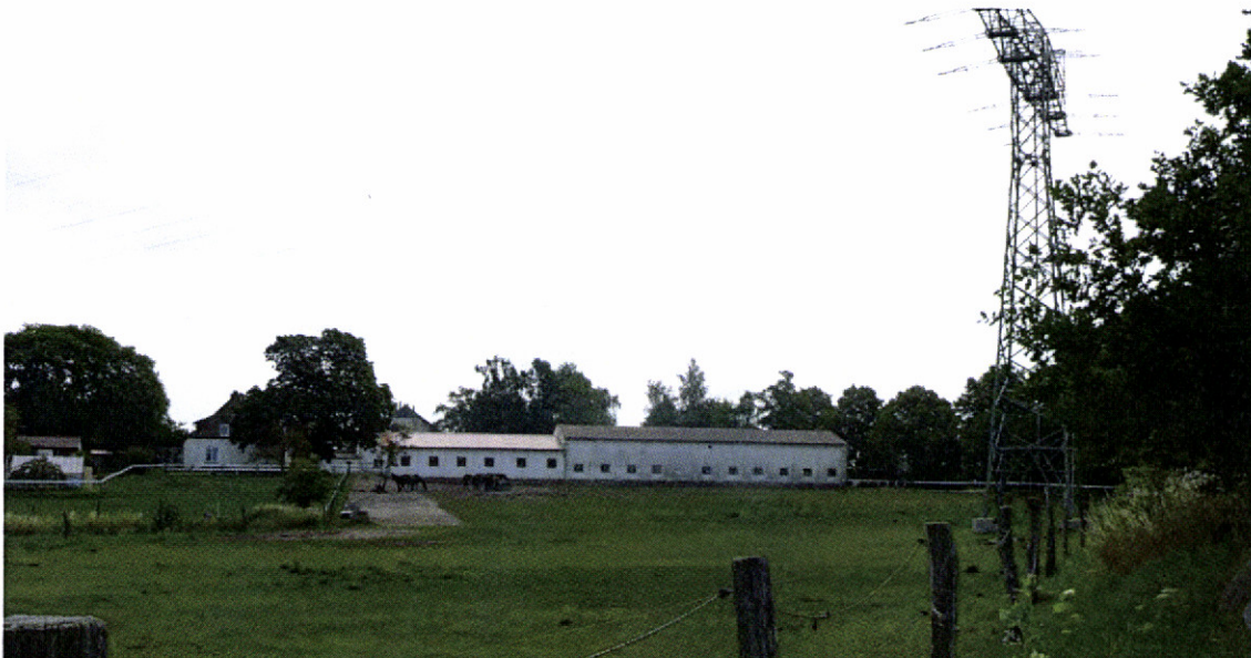
Abbildung 19: bestehendes Stallgebäude, gem. B-Plan der Bereich mit den Nutzungsoptionen 6 Reitplatz, 1 Mehrzweckhalle und 5 Gästebetreuung. Foto: STADT LAND FLUSS 18.07.2018.
