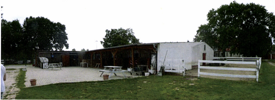
Abbildung 17: Stallgebäude nördlich des Wohnhauses, gem. B-Plan Bereich 3 – Stall. und Freigehege. Foto: STADT LAND FLUSS 18.07.2018
