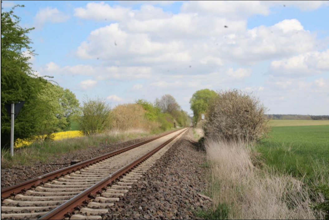
Abbildung 6: Locker mit Gebüsch bestehender Bahndamm im Osten des Plangeltungsbereiches.
