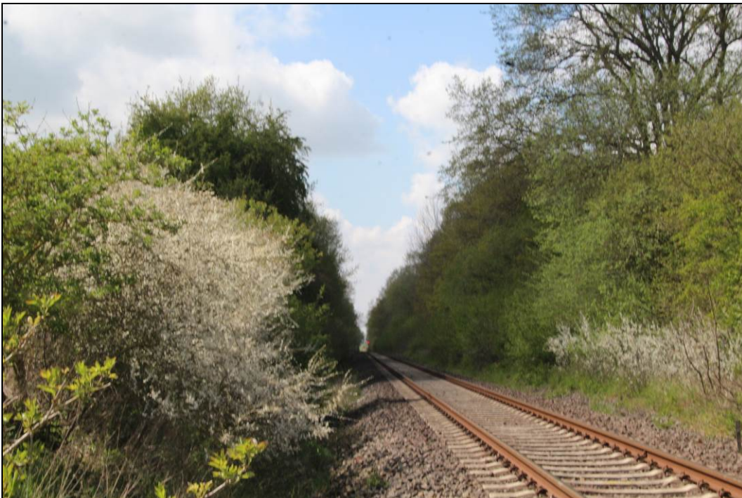
Abbildung 5: Tief eingeschnittener Bahndamm in der Mitte des Plangeltungsbereiches.
