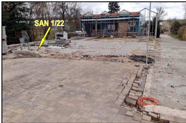
Abb. 1: Rammkernsondierung SAN 1/22 im Bereich des bereits oberirdisch zurückgebauten Verkaufsbauwerkes der ehemaligen Gärtnerei
