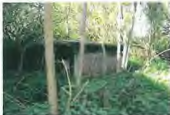
Schuppen mit Asbestdach hinter dem Wohngebäude
