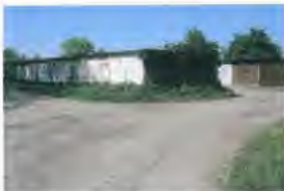
Garagenkomplex an der südwestlichen Grenze des Plangebietes
