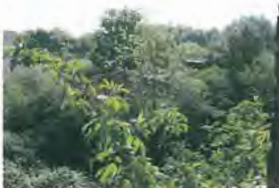
Ruine des Wirtschaftsgebäude in der Brachfläche
