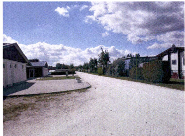
Zentrales Sanitärgebäude mit Fahrweg und Standplätze für Dauercamping.
