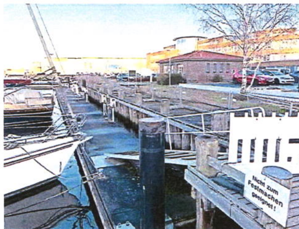
Der Brunkowkai wird komplett erneuert.
