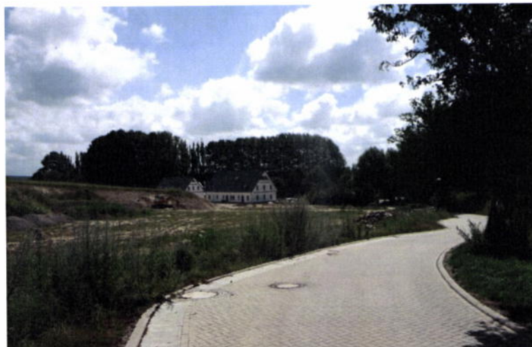
Foto 1: vorhandene Erschließungsstraße „Am See“ mit vorhandenen Ferienwohnungen (2015)
