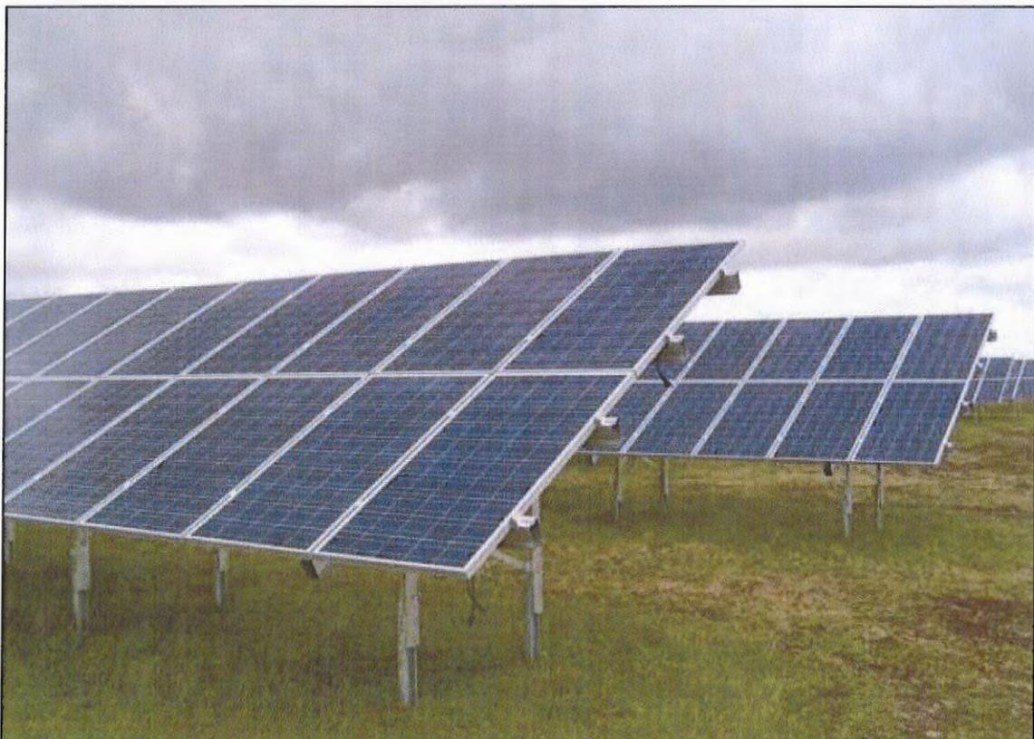
Abbildung 4: Detailansicht der zweireihigen Modultische. Quelle: S.I.G. 2012.
