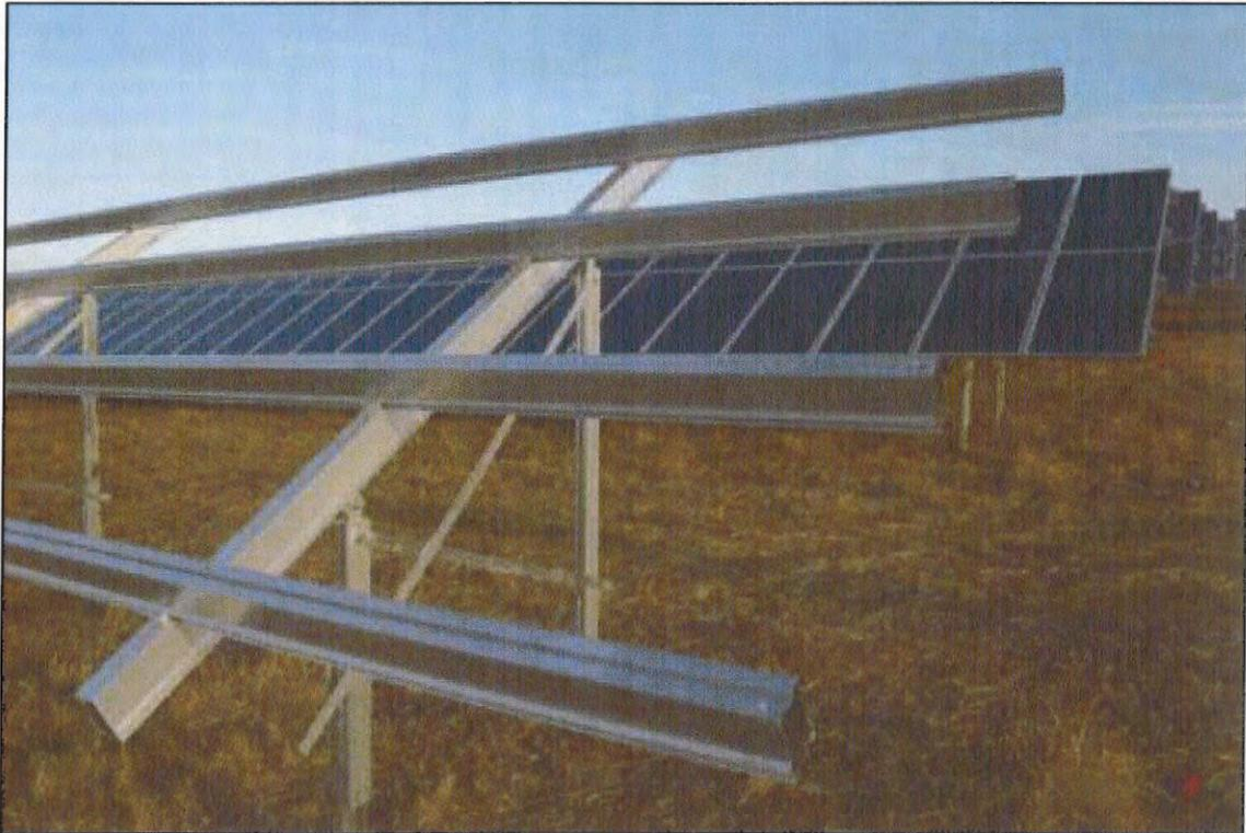
Abbildung 3: Systemdarstellung zur Aufständigung der Gestelleinheiten. Quelle: S.I.G. 2012.
