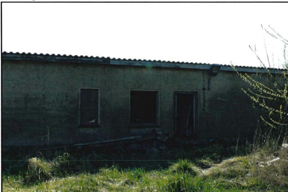
Abbildung 7: Ehemaliges Sanitärgebäude südlich der Werkstatt
