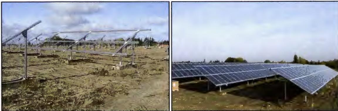
installieren. Abbildung 3: Detailansichten der zweiteiligen Modultische auf Fundamentplatten. Quelle: SIG 2012.
