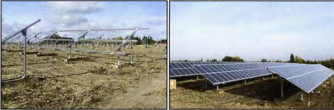
Abbildung 2: Systemdarstellung zur Aufständigung der Gestelleinheiten und Fundamentierungsvariante auf Bahnschwellen. Quelle: S.I.G. 2012.
