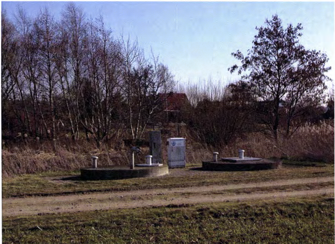
Abbildung 4: Einlaufbauwerk mit Vorklär- und Speicherbecken
