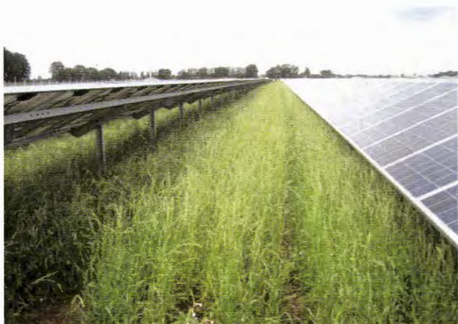
Bauweise einer Photovoltaikanlage
