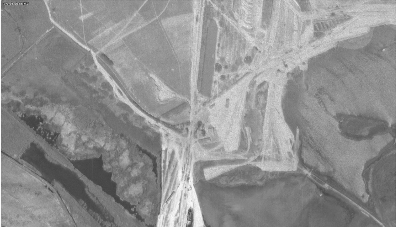
Abbildung 2: Historisches Luftbild von 1953, Bauarbeiten zum Rügenhafen überprägen die Landschaft und Vegetation um die Siedlung Weddeort (Quelle: MVBio Pro)
