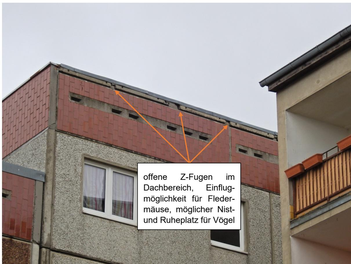
**Abbildung 9: Rückseite Rossstraße 1 - offene Z-Fugen im Dachbereich**
