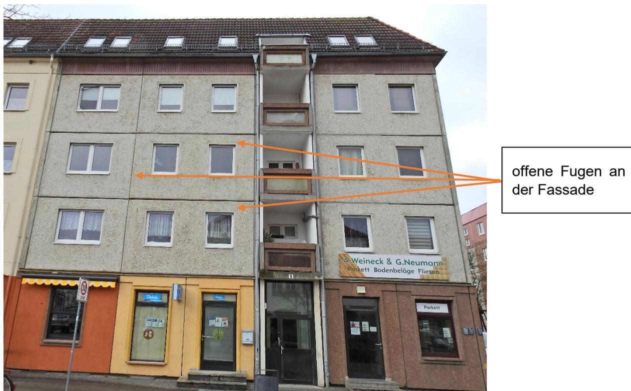
Abbildung 5: Am Markt 5 - offene Fugen zwischen den Fassadenplatten
