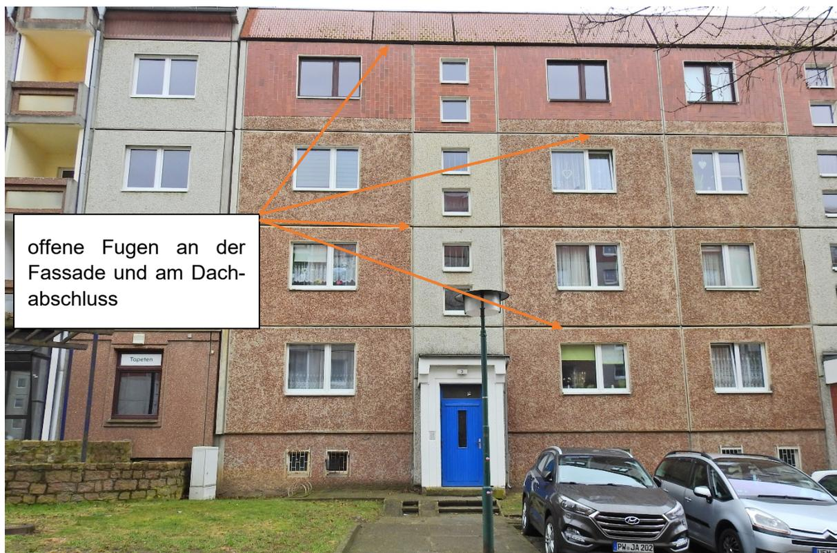
**Abbildung 6: Rossstraße 3 - offene Fugen zwischen den Fassadenplatten und am Dachabschluss**
