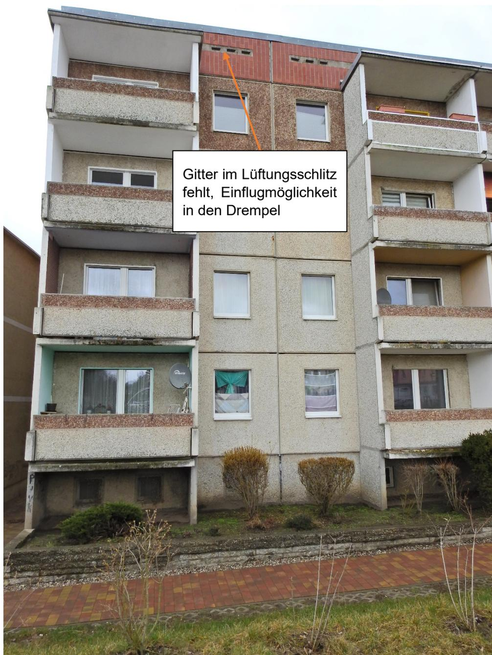
**Abbildung 8: Rückseite Rossstraße 9 - Lüftungsschlitz im Drempel offen**
