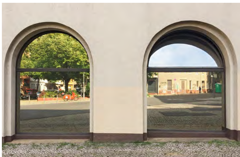
Spiegelnde Sonnenschutzfolien erzeugen realistische Spiegelbilder: Vögel nehmen diese Fenster als Durchflugsopion wahr.
