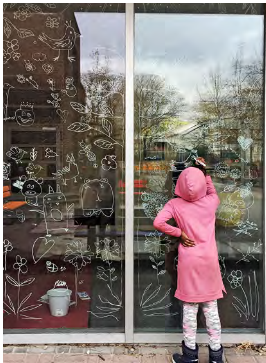
Bei dieser kreativen Markierung werden die Motive über die gesamte Fläche verteilt, ohne grössere Lücken freizulassen. Dennoch ist die Sicht nach aussen nicht stark eingeschränkt und der Lichteinfall ist weiterhin gewährleistet.
