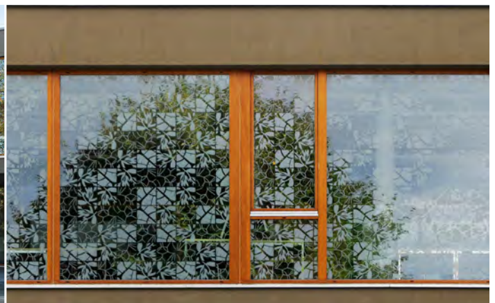
Aufgrund der starken Spiegelungen von Vegetation auf der Fensterfront der Kantonsschule Beromünster kam es zu häufigen Vogelkollisionen. Daher wurden vor ca. 20 Jahren Greifvogelsilhouetten angebracht, mit denen jedoch keine Besserung der Situation erreicht wurde. In einem Schulprojekt wurde daraufhin von Jugendlichen eine kreative Fenstermarkierung entworfen, die den Anforderungen eines wirksamen Vogelschutzes entspricht.
