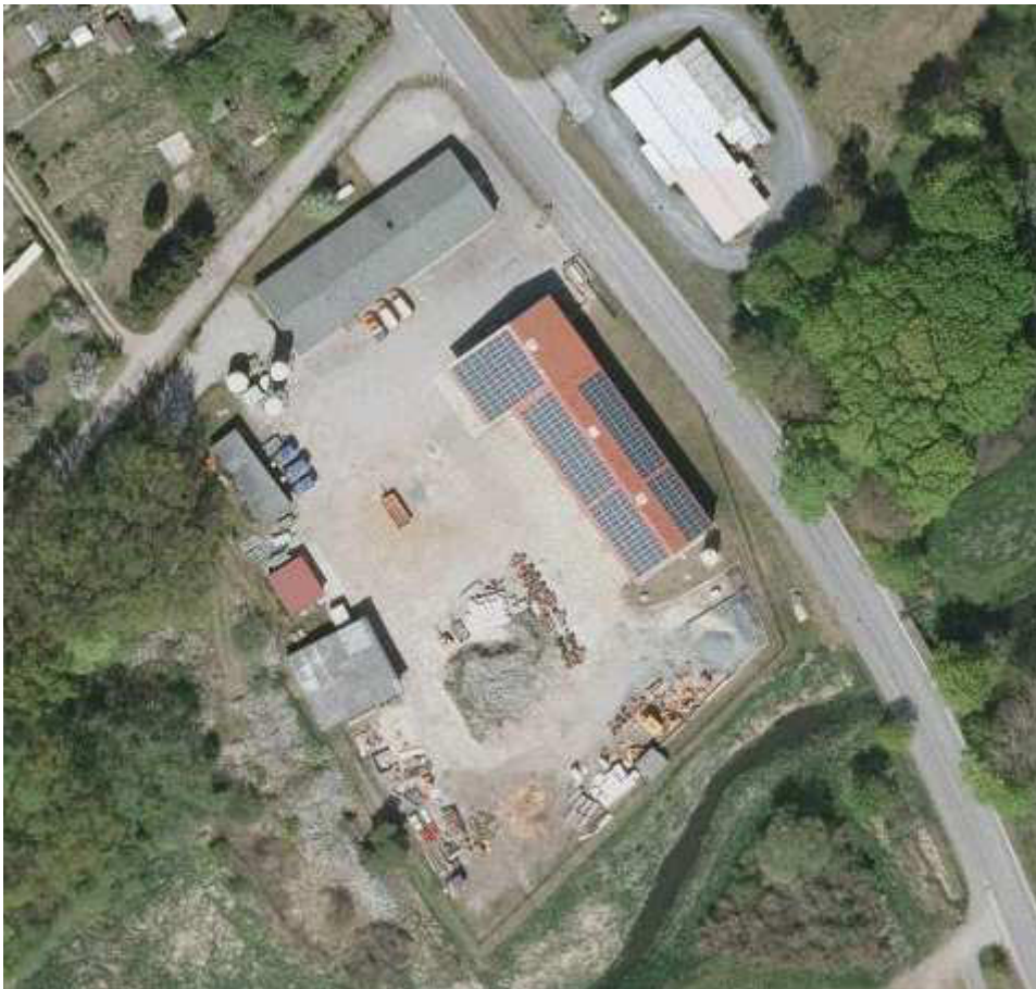
Abbildung 2: Luftbild der Kreisstraßenmeisterei (Quelle: https://www.geoportal-mv.de/gaia/gaia.php , Zugriff 12.9.23)
