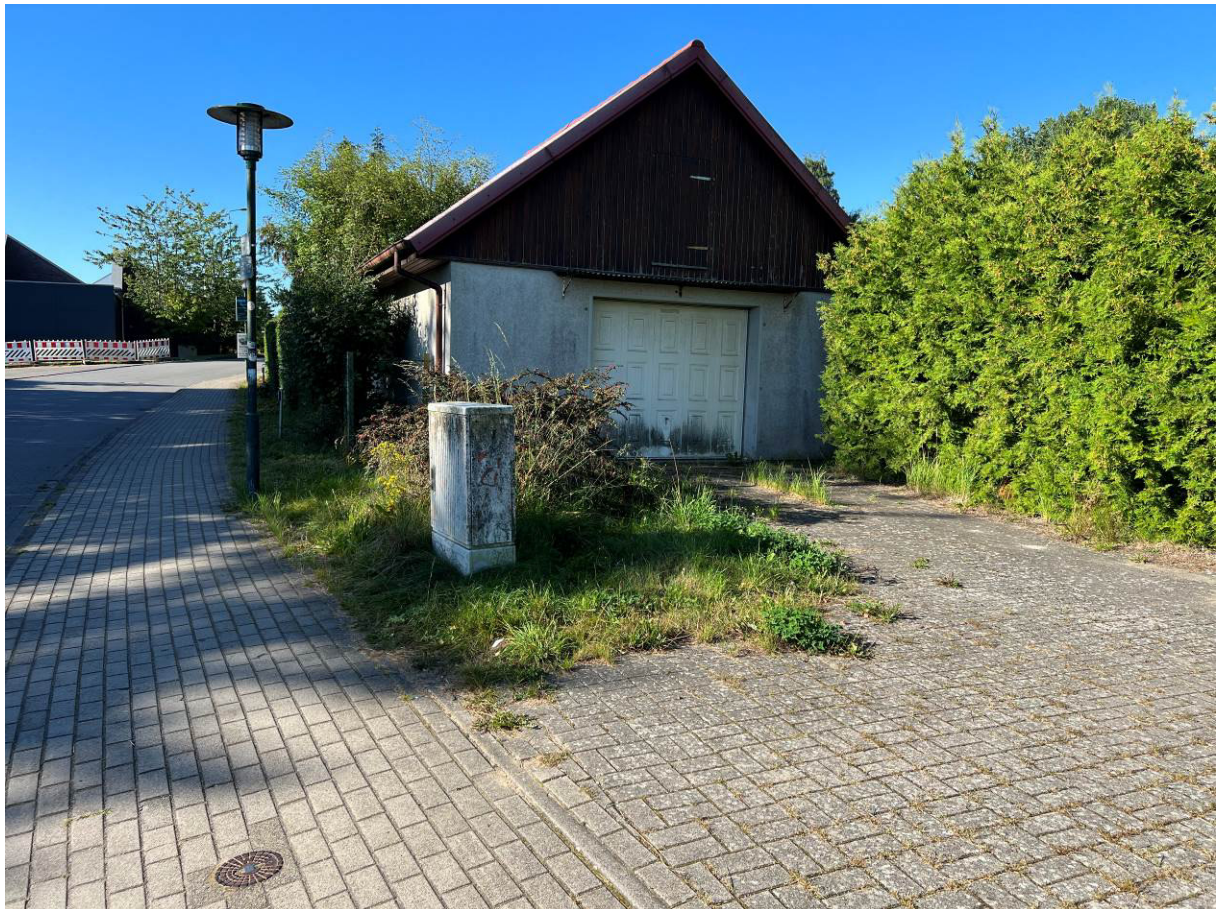
Foto 11: Versiegelte Wegeflächen (OVW, OVF), Gebäude (O) Rabattenbereiche (PEB) sowie Siedlungshecke aus nichtheimischen Gehölzen (PHW) am Ostrand des Plangebietes
