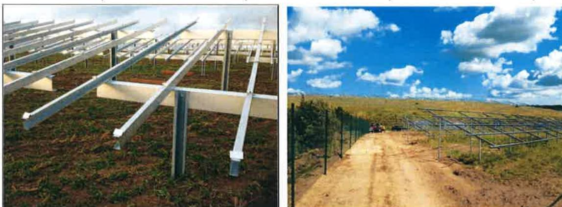
Abbildung 4: Unterkonstruktion und Zaunbau auf einer PV-Anlage (Quelle: Vicona)
