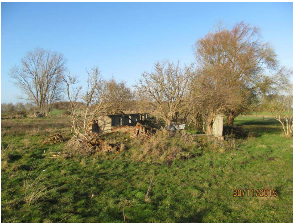
Abbildung 1: Ruinöse Stallanlage im Plangebiet
