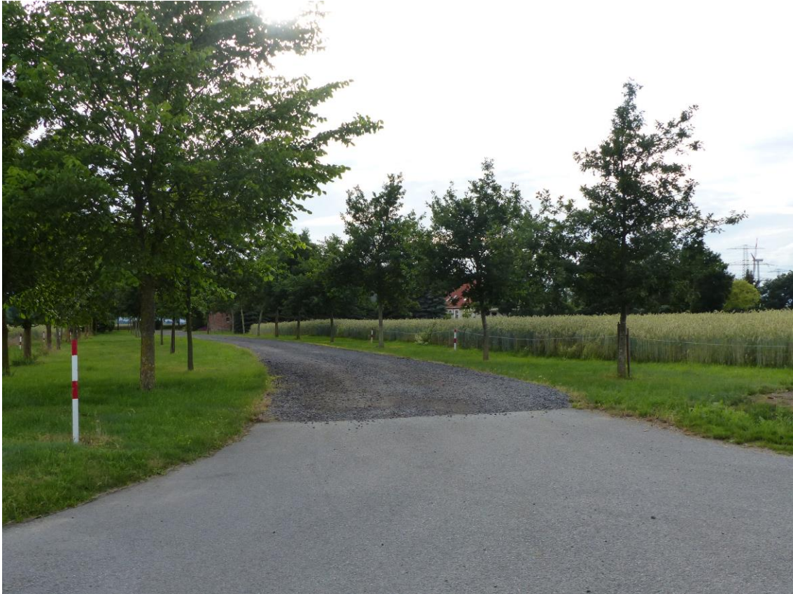
Abbildung 14: Blick von Osten auf Geltungsbereich, teilversiegelte Schotterfläche mit begleitender Allee und Baumreihe in Richtung Gebäudebestand, optisch durch Bäume abgeschirmt. Foto: SLF 01.07.2020.
