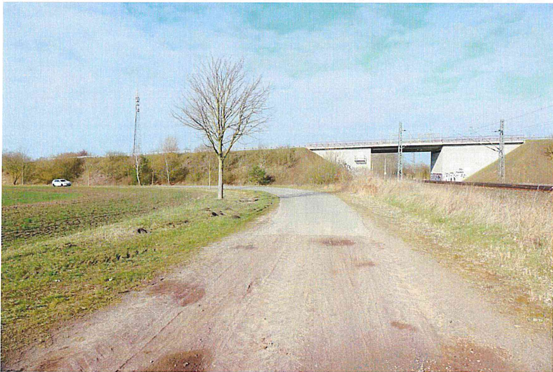
Abbildung 14: Die Umgehungsstraße ist aufgrund ihrer erhöhten Trassenführung über die Bahnstrecke weithin sichtbar, ebenso der weiter westlich stehende Funkmast (Bildhintergrund links). Foto: SLF 17.03.2021.
