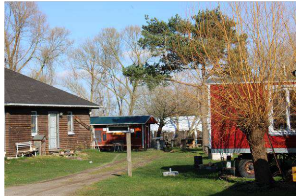
Abbildung 21: links Hauptbetriebsgebäude, angrenzende Gebäude und Baumbestand
