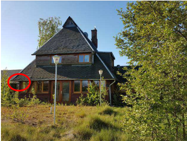
Abbildung 26: ehemalige Badeanstalt, Hauptgebäude mit Beispiel für pot. Quartiermöglichkeiten; hier: im Bereich der Dachrinne
