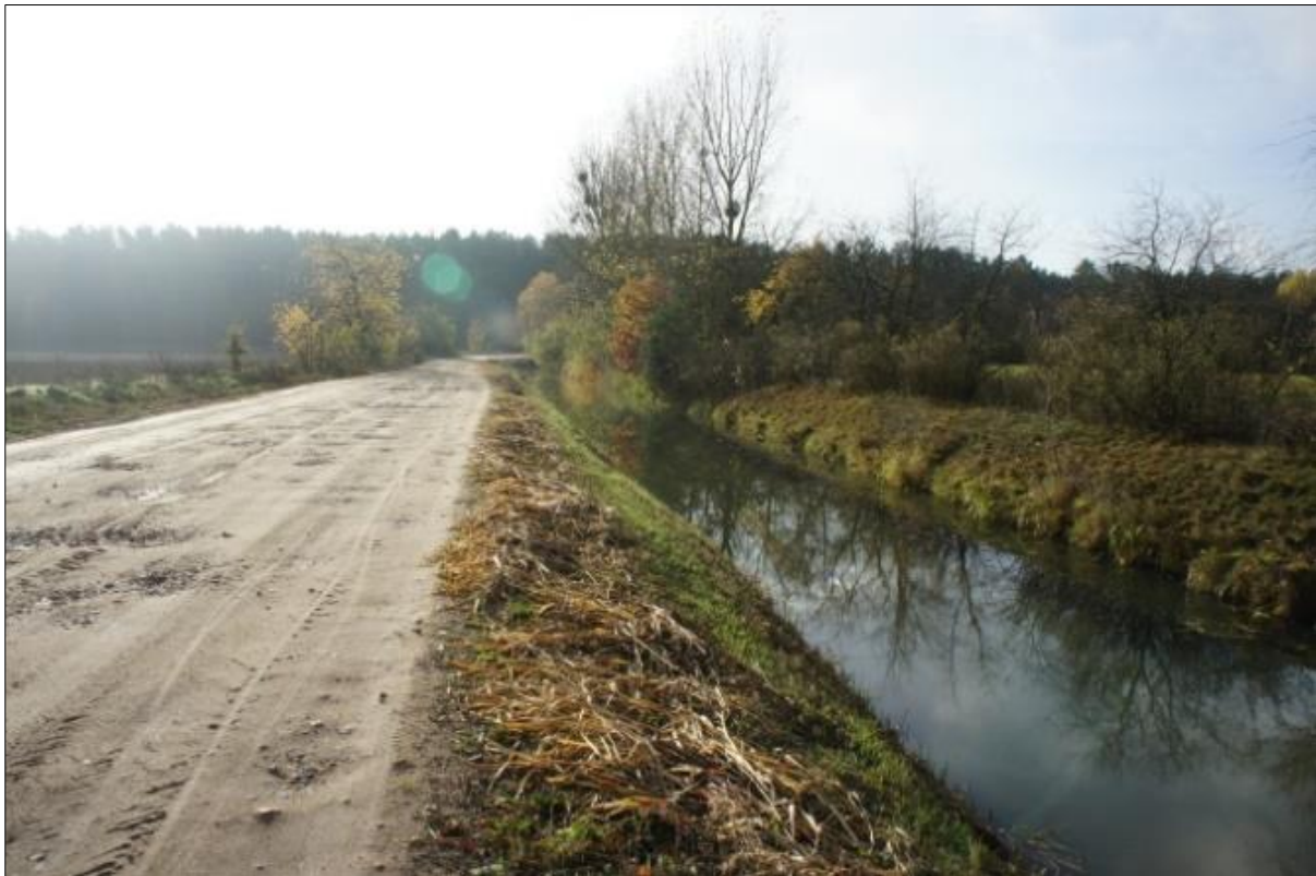
Abb. 9: Unbefestigter Weg (OVU) an der westlichen (linkes Bild) und südwestlicher (rechtes Bild) Plangeietsgrenze; Aufnahmedatum 12.11.2020
