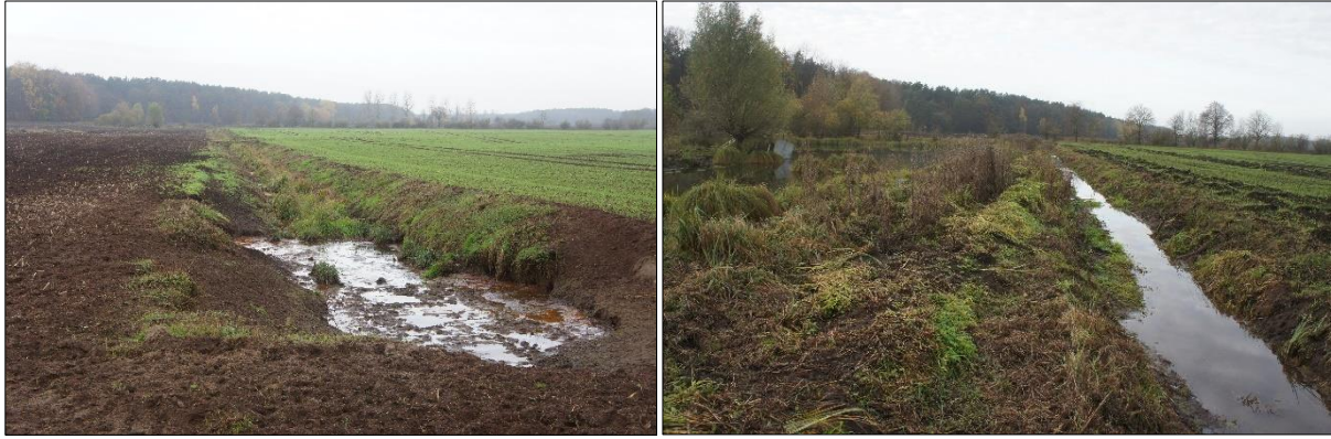
Abb. 10: Graben mit intensiver Instandhaltung innerhalb des südlichen Plangebiet und Entwässerung in den Bresegarder Mühlbach und parallelen Verlauf zu permanenten Kleingewässer (rechtes Bild); Aufnahmedatum 12.11.2020
