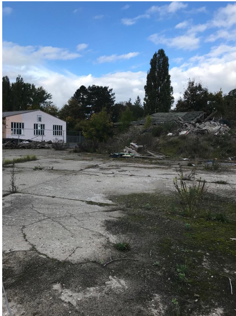
Foto: zentrale Betonflächen, links oben: Nachbarbebauung
