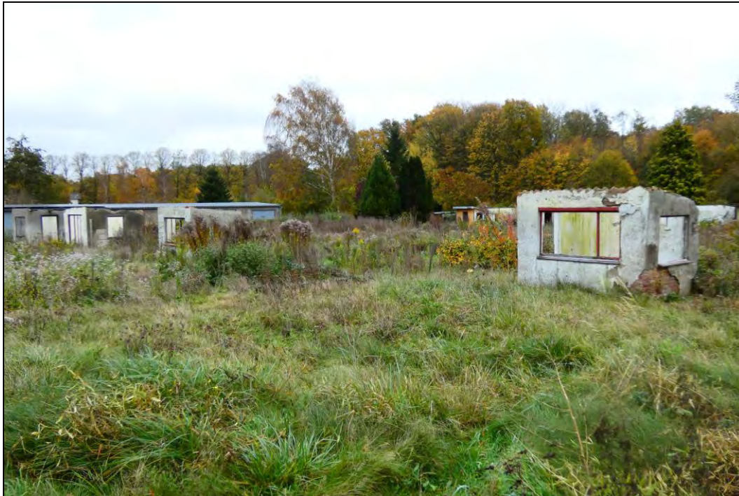
Abbildung 3: Ansicht der aufgelassenen und teilweise entkernten Gartenlauben (zwischenzeitlich abgebrochen und beräumt).
