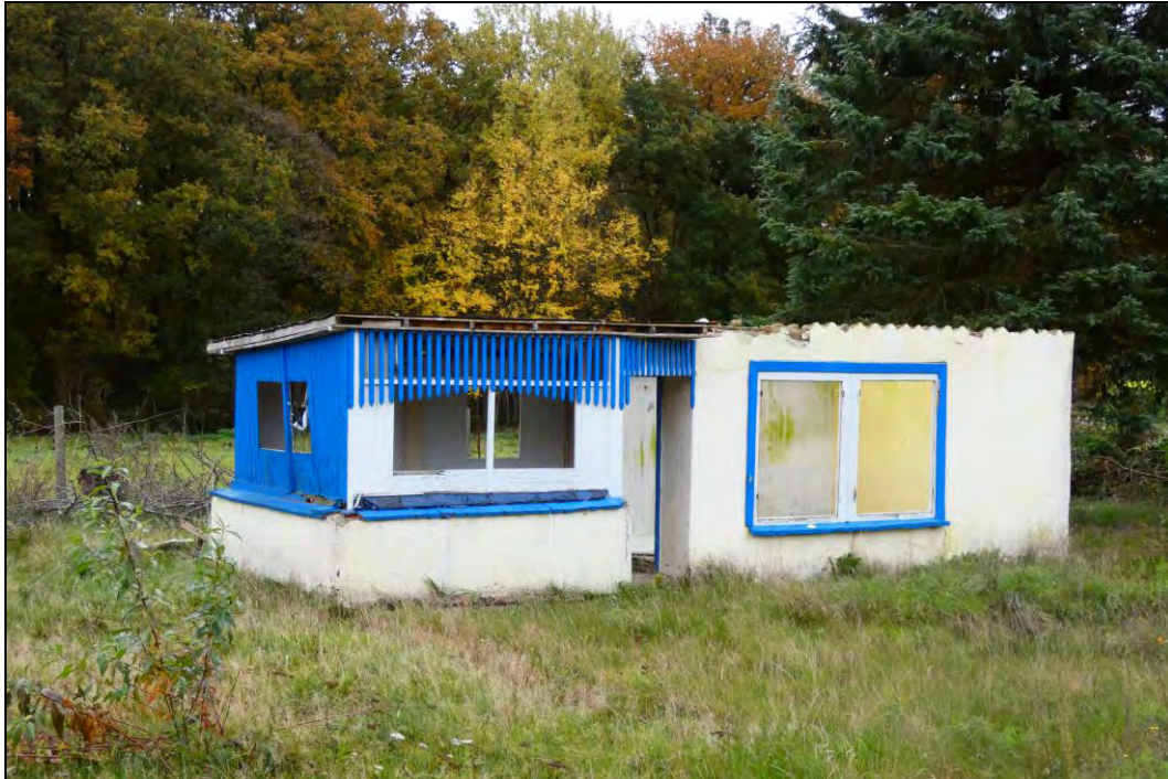
Abbildung 5: Ansicht der aufgelassenen und teilweise entkernten Gartenlauben (zwischenzeitlich abgebrochen und beräumt).
