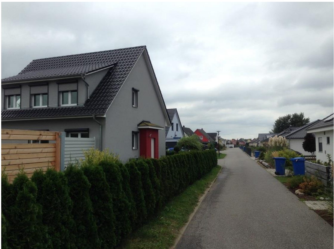
Abb.8: Bebauung J.-H.-Wilken-Str. Fenster und Verkleidungen (Okt. 2020), Blickrichtung: West
