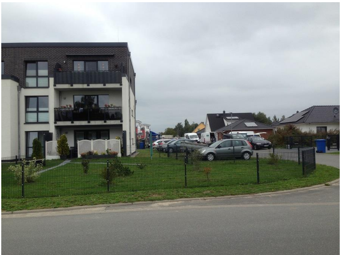
Abb.10: Mehrfamilienhaus Käthe-Miethe-Str. Ecke Sanitzer Str. – Mehrfamilienhaus mit Reflexionsaspekt und Plissees; Blickrichtung: Nord
