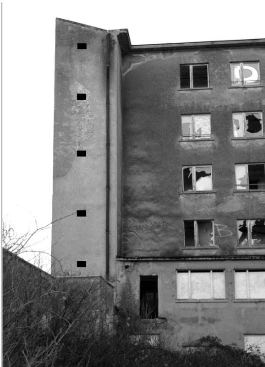
**Abb. 10:** Durch die Öffnung von fünf Toträumen am nördlichen Giebel des Hochbaukomplexes können bis zu 10 Rauchschnalben-Brutplätze geschaffen werden. Die Öffnungen werden dauerhaft offen gehalten. Die Toträume haben ein Volumen von je ca. 10 m<sup>3</sup>.
