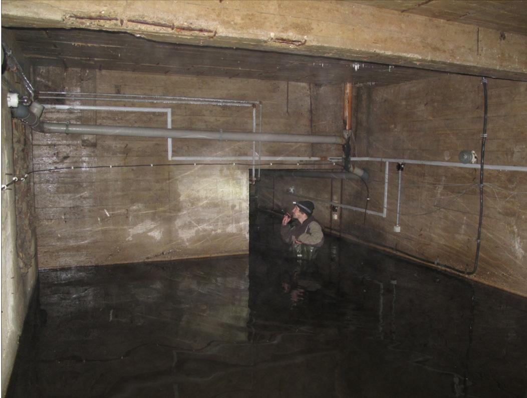
**Abb. 5:** Feuchtes Winterquartier unter dem westlichen und zentralen Teil des Gemeinschaftshauses. Der Wasserstand beträgt hier etwa 1,3 m. Die Räume weisen stabile kühl-kalte Temperaturen und eine relative Luftfeuchtigkeit von 100 % auf.
