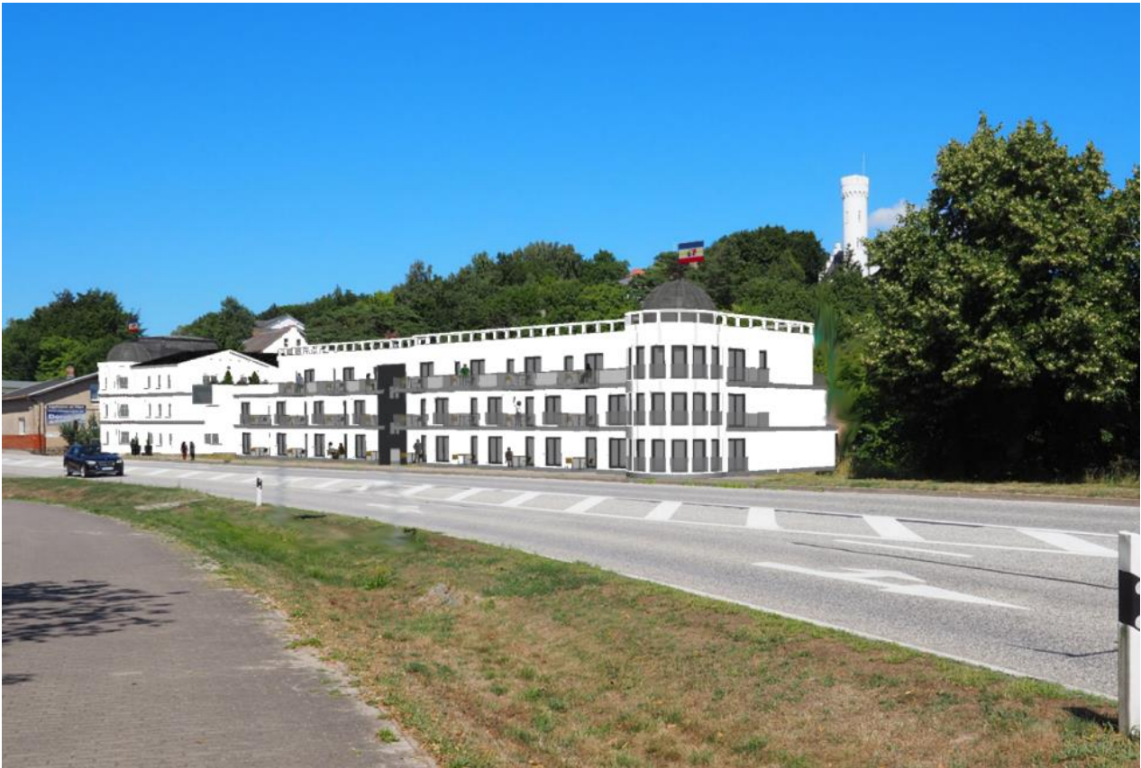
Abbildung 9: Ansicht auf die Westfassade, Stand 2020
