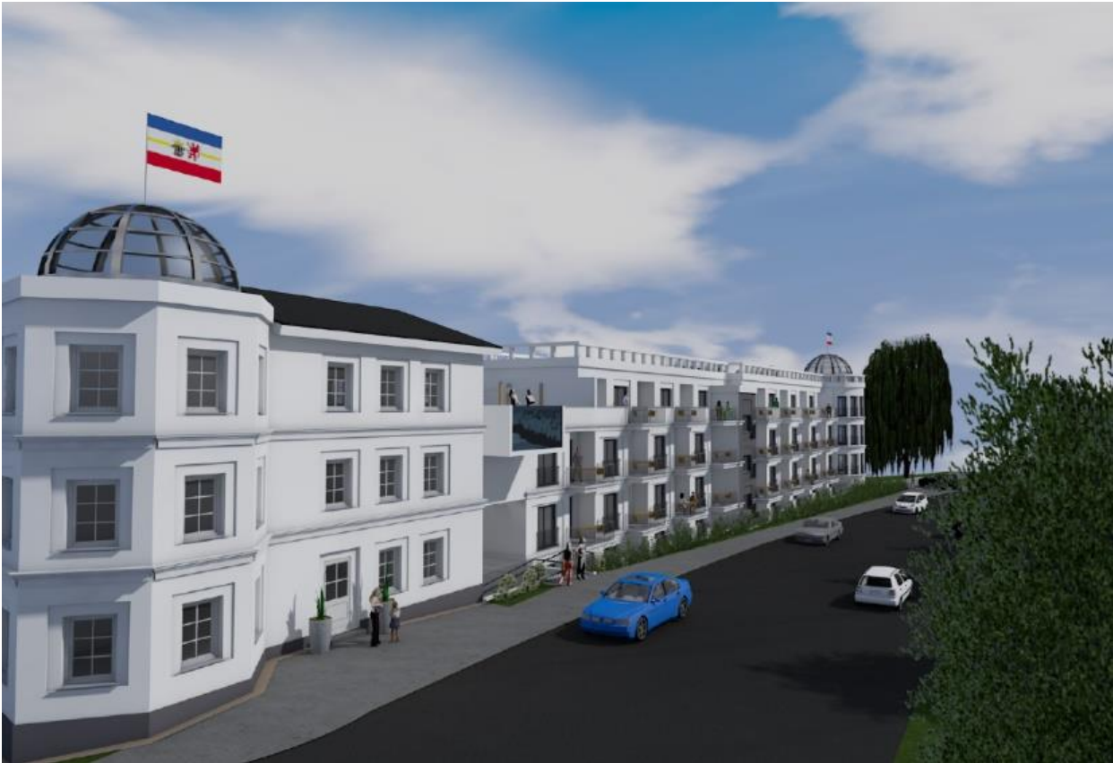
Abbildung 11: Ansicht auf die Westfassade von Norden kommend, Stand 2020
