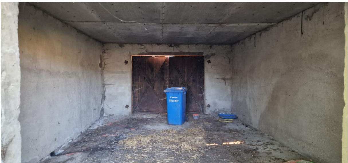
Abbildung 32: Innenbereich des Gebäudes Nr. 10.
