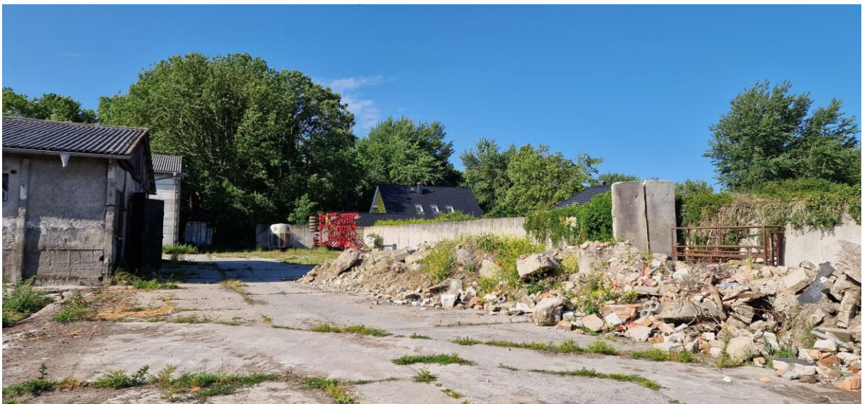
Abbildung 19: Blick aus Norden auf die Schuttablagerungen auf der Westseite.
