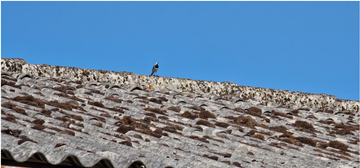
Abbildung 24: Revieranzeigende Bachstelze auf Gebäude Nr. 7.
