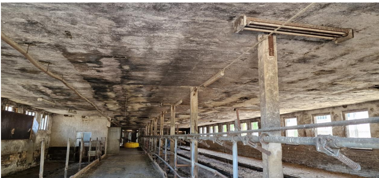
Abbildung 13: Innenbereich des Gebäudes Nr. 5.
