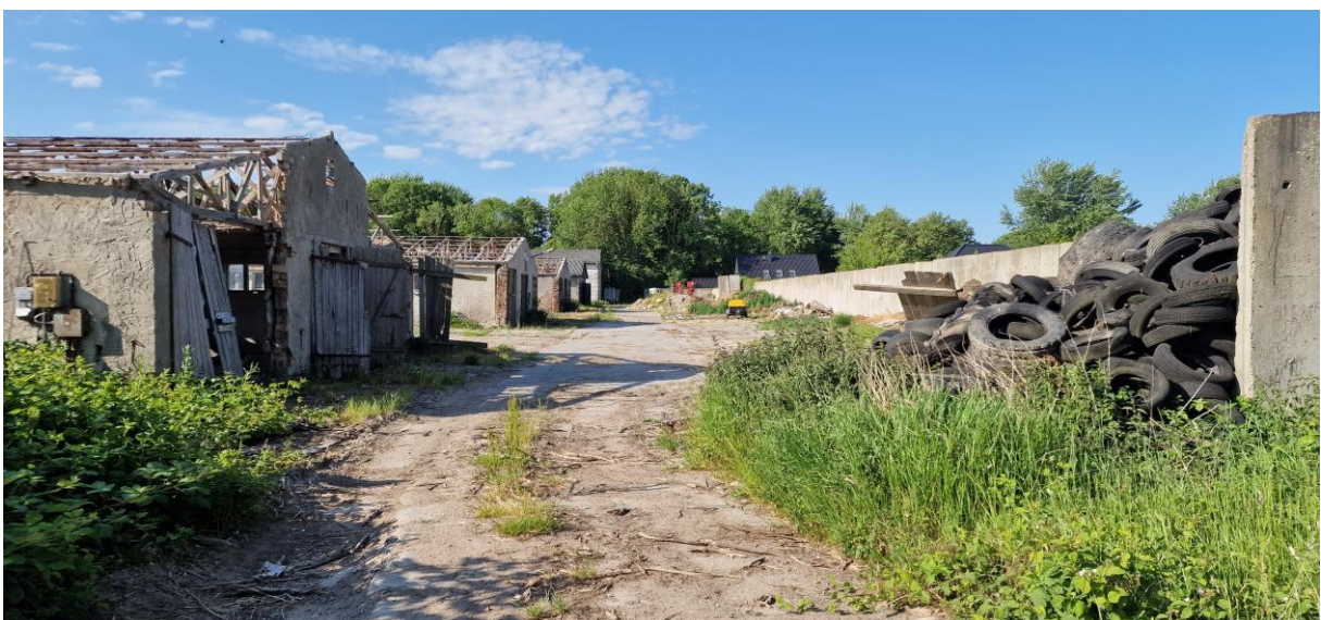
Abbildung 26: Blick aus Norden auf den westlichen Bereich des Gebiets, links die Gebäude Nr. 2-4 ohne Dach.
