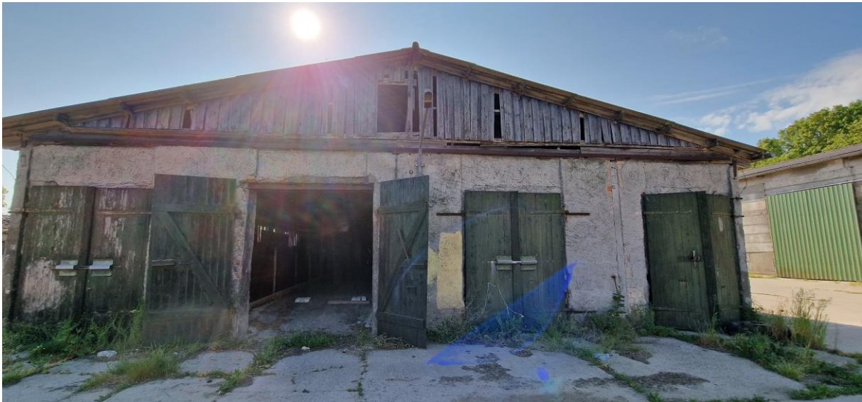
Abbildung 12: Gebäude Nr. 5 von der Westseite.
