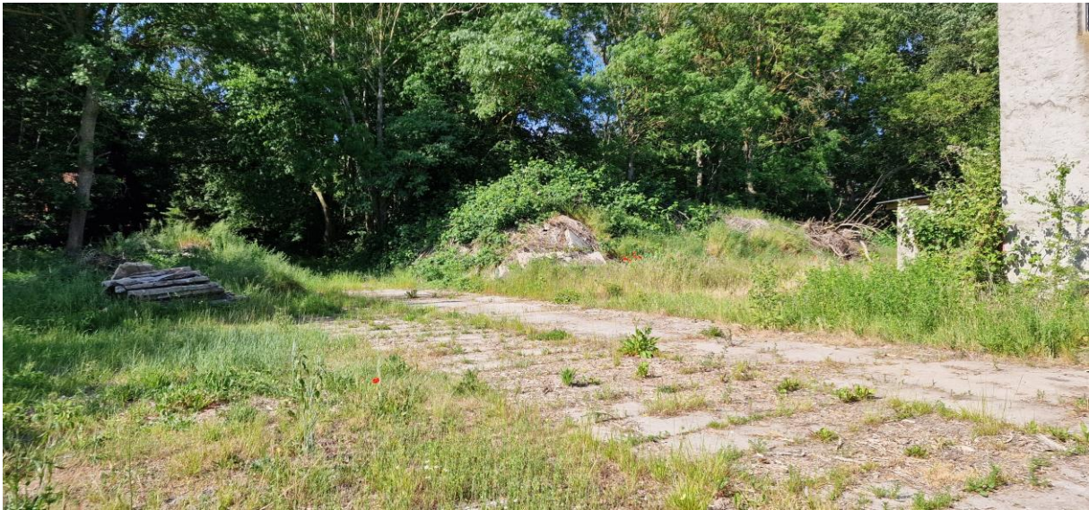
Abbildung 9: Ablagerungen südlich des Gebäudes.
