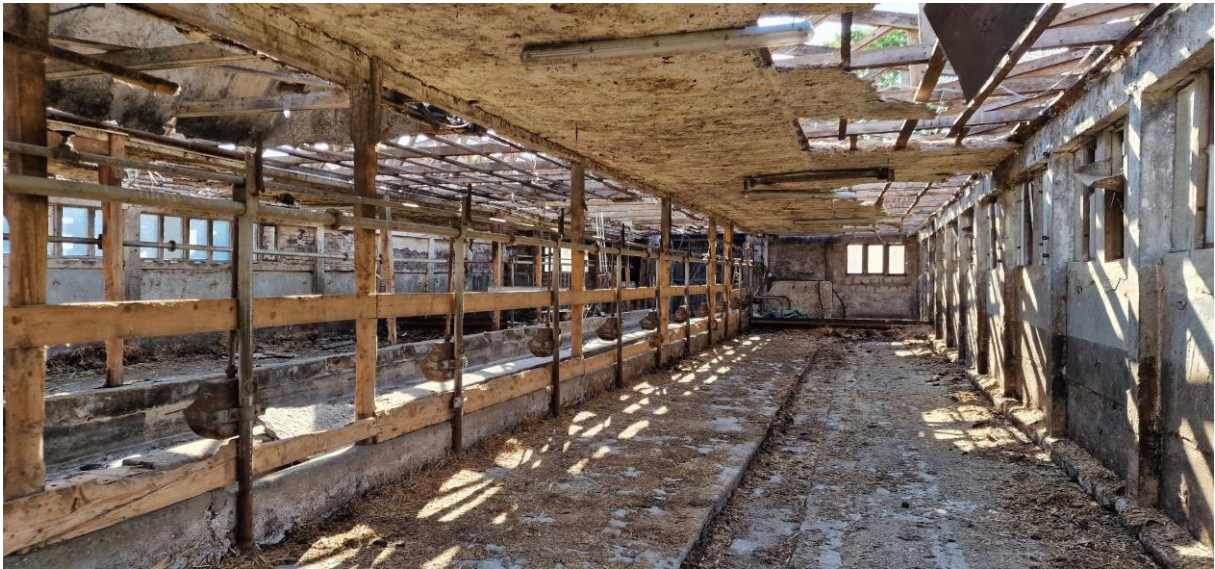
Abbildung 21: Innenbereich des Gebäudes Nr. 4, die Dacheindeckung wurde schon entnommen.
