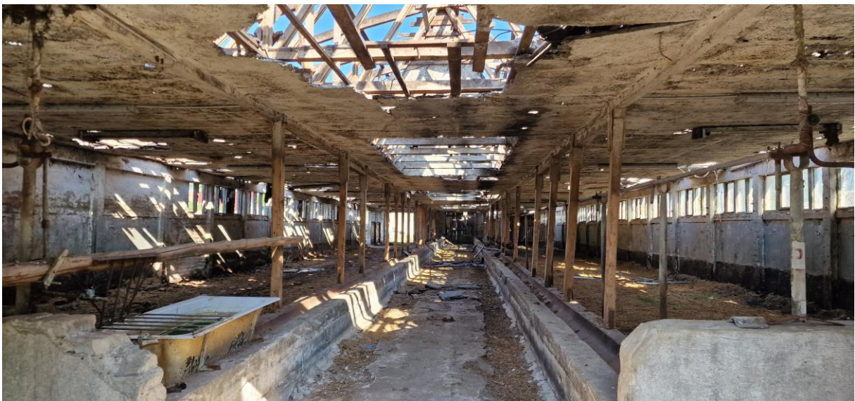
Abbildung 25: Innenbereich von Gebäude Nr. 3.
