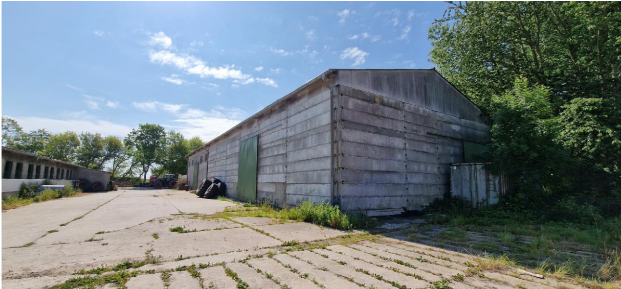
Abbildung 6: Gebäude Nr. 6 im Süden des Geltungsbereichs.
