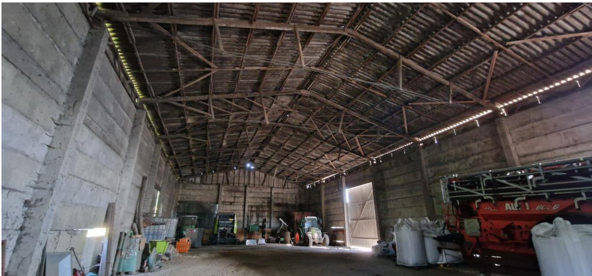
Abbildung 7: Innenbereich des Gebäudes Nr. 6.
