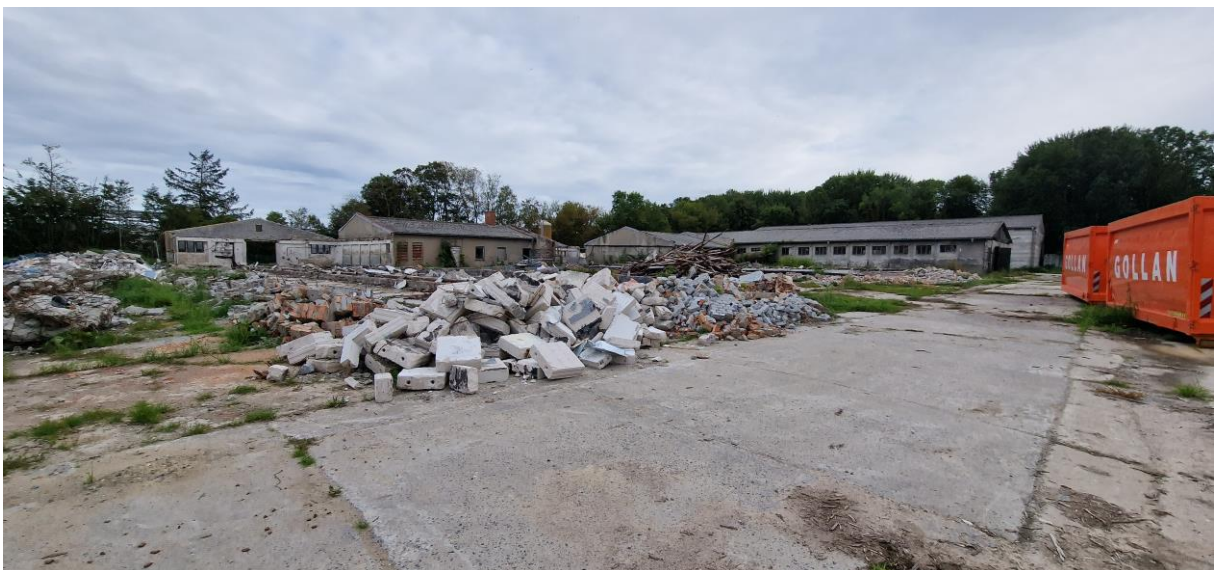
Abbildung 35: Schuttreste nach den Abbrucharbeiten an den Gebäuden Nr. 2-4.
