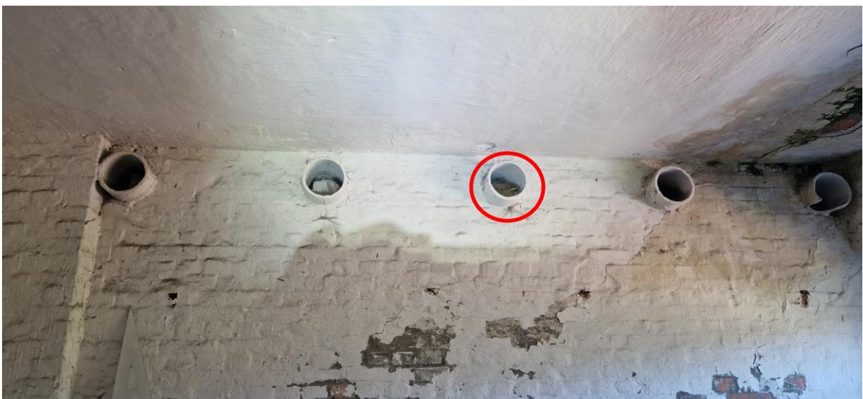
Abbildung 32: Die Röhren in den Wänden waren teilweise mit Nestern belegt.
