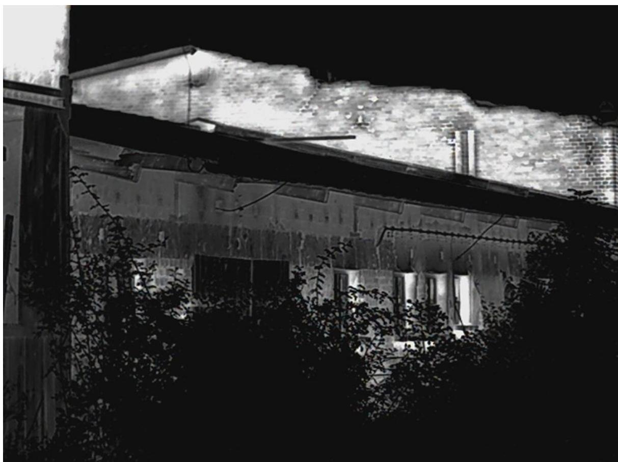
Abbildung 49: Südwestseite von Gebäude 1 im Wärmebild.
