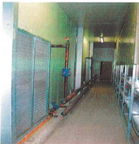
Wärmegang mit Wärmetauscher parallel zum Trockner (rechts)
