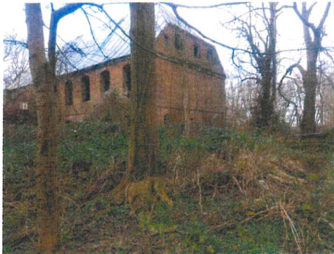
Abbildung 2: Blick auf das Baugrundstück
