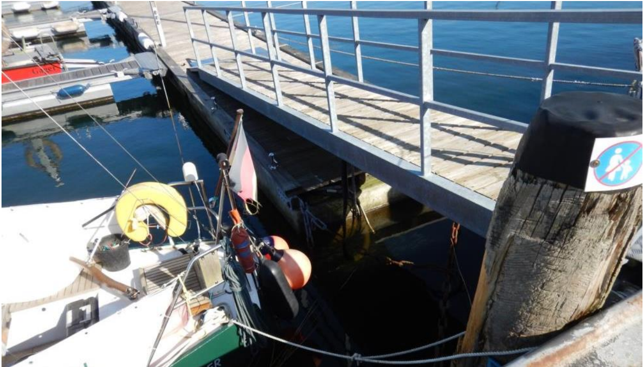
Abbildung 10: Schwimmsteg an der südlichen Kaimauer.
