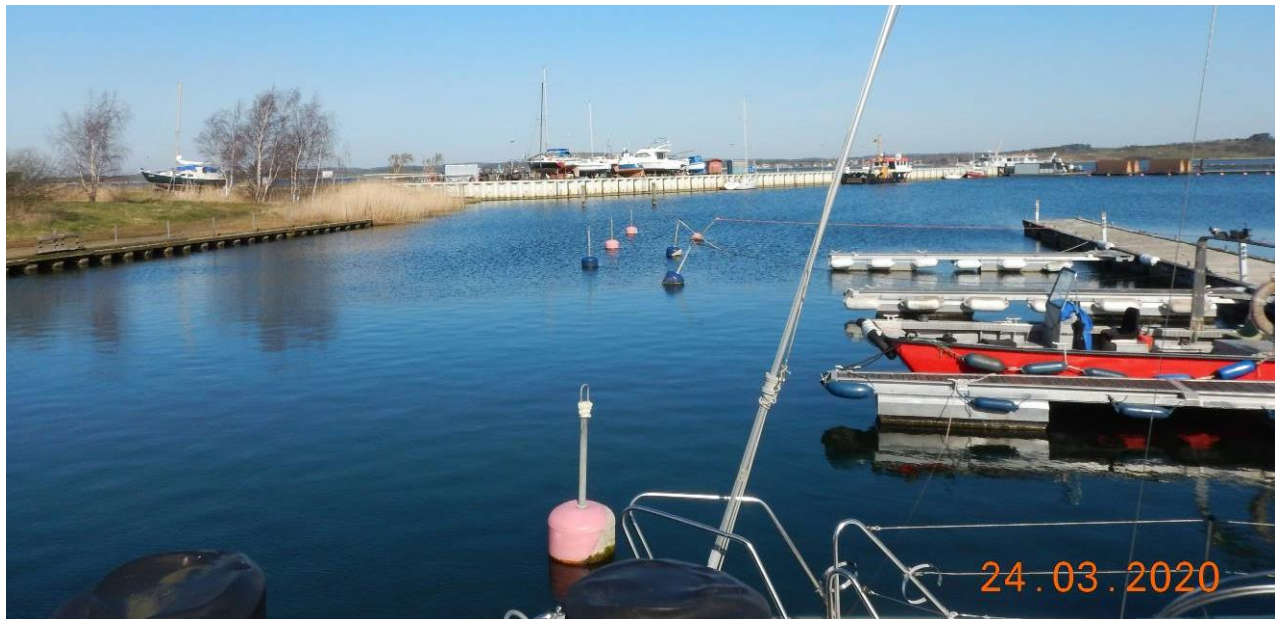
Abbildung 8: V.l.n.r.: Grünfläche, Röhricht (dahinter die Slipanlage), Molenkopf mit Schwimmsteg, Schwimmsteg an der südlichen Kaimauer
