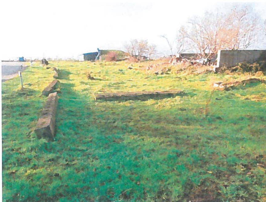
Abbildung 2: Südlicher Teil des Änderungsbereichs mit Blick zum Wasserspeicher
