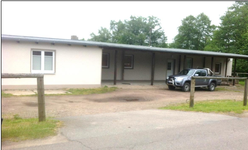
Abb. 4: Bestandsgebäude (ehemalige Stellmacherei) mit Abfahrt von der öffentlichen Straße
