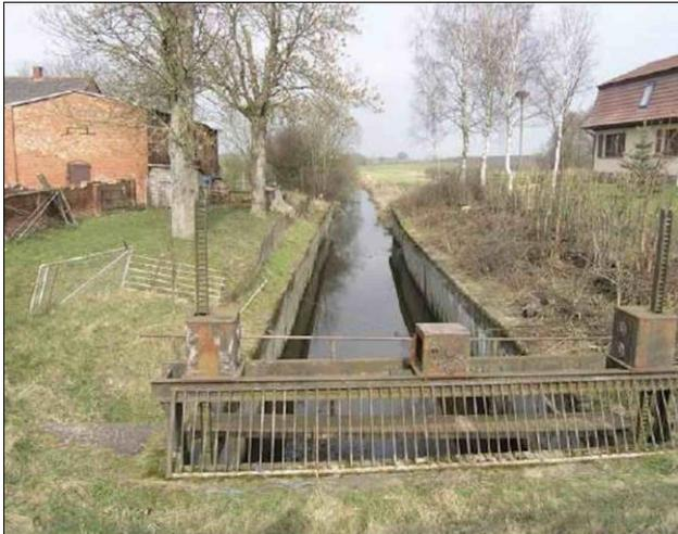
Abbildung 5: Wehranlage Paarsch vor dem Rückbau
