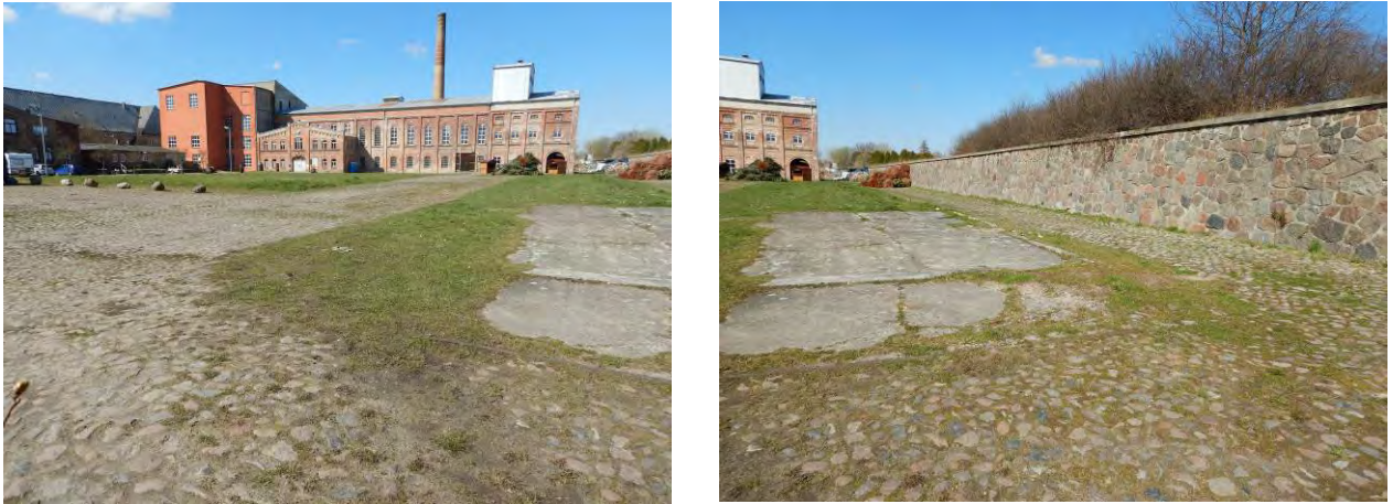
Abb. 17 u. 18: Links: ehemalige Zuckerfabrik mit Umfeld; rechts: Mauer am ehemaligen Bahndamm (südlich an das Plangebiet angrenzend)
