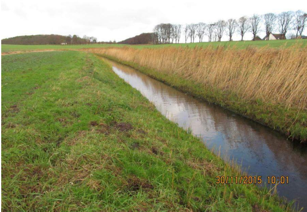
Abbildung 4: Graben östlich des Plangebietes
