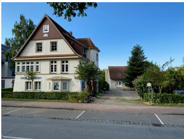
Abb. 2: Vorhandene Bebauung innerhalb des Plangebietes, eigene Aufnahme.
