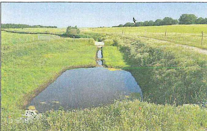
Das Regenrückhaltebecken in Erdbauweise.
