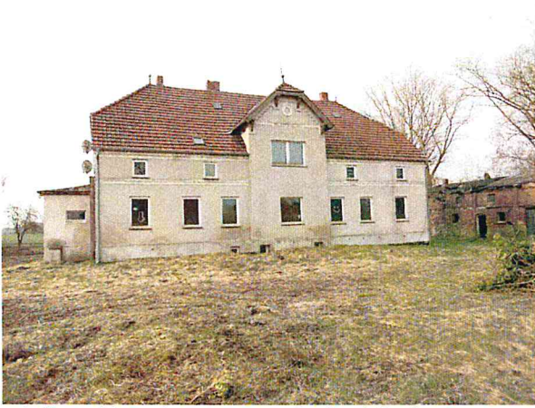
ruinöses Haupthaus sowie Stallgebäude
