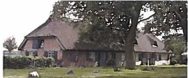
Abbildung 3: sanierte Landarbeiterkaten in Volkshagen
