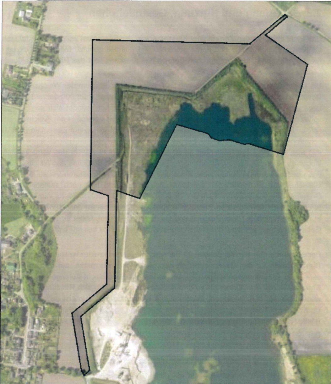
Abbildung 3: Luftbild zur aktuellen Nutzung des Bebauungsplangebietes
