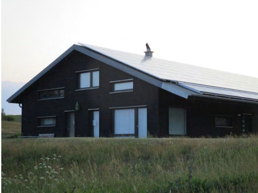
Übersicht Plangebiet – Hauptgebäude nach Sanierung (PLANUNGSBÜRO SEPPELER 5/2018)
