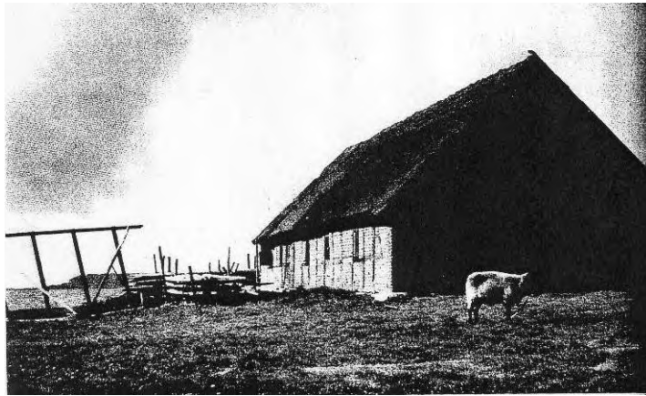
vormaliges Fachwerkgebäude, Quelle unbekannt, 1957
