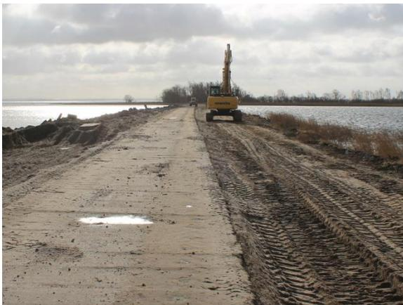
**Abbildung 34 Rückbau des Damms zur Insel Görmitz**
